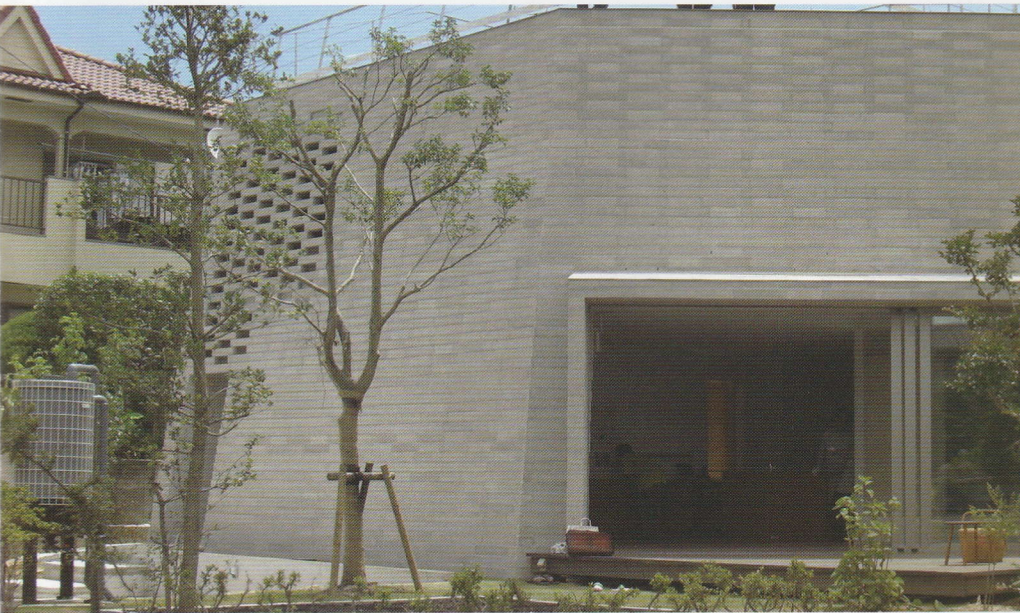
建築用シラスブロックを積層し、内外の壁間には140mmの空気層が設けられている。
