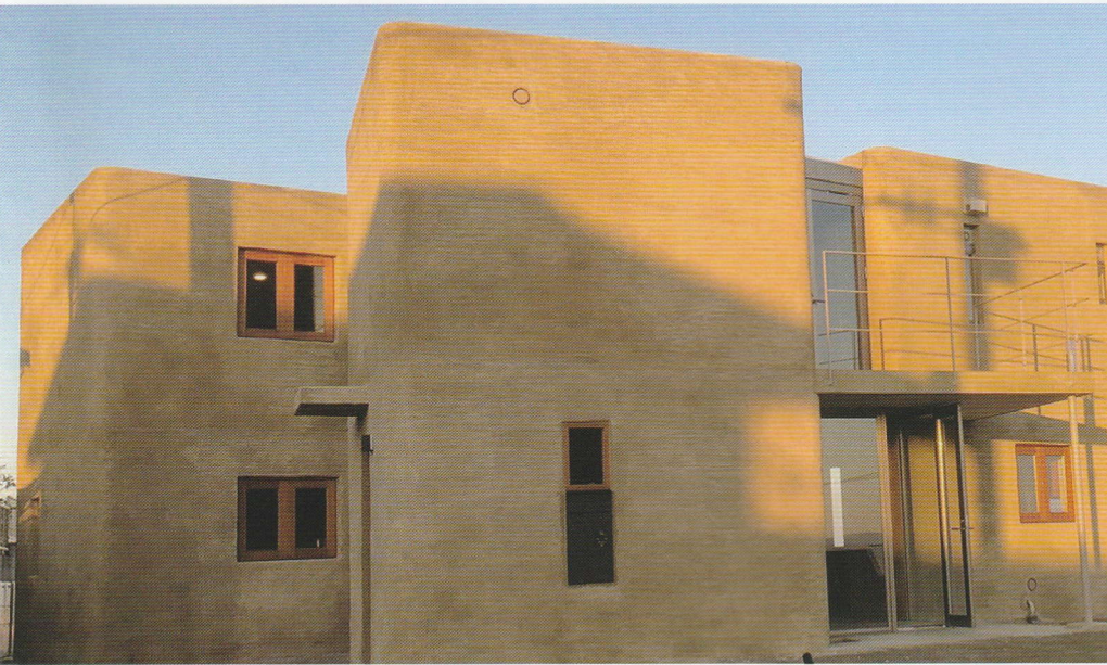
南九州一帯に堆積する火砕流堆積物の「シラス」を素材にしたシラスブロックを構造材として使用。
