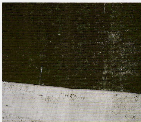
施工完了より3年後
