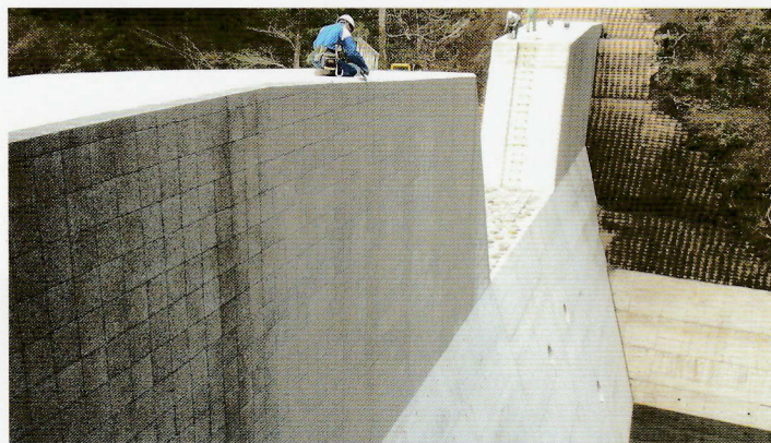
シラス平板施工完了
