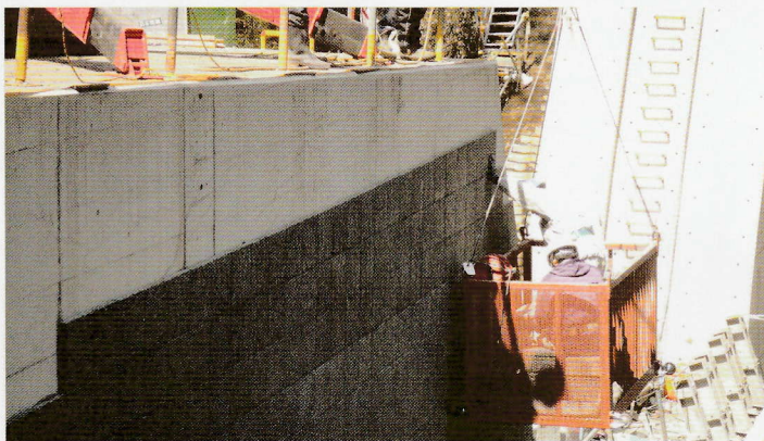
シラス平板施工中
